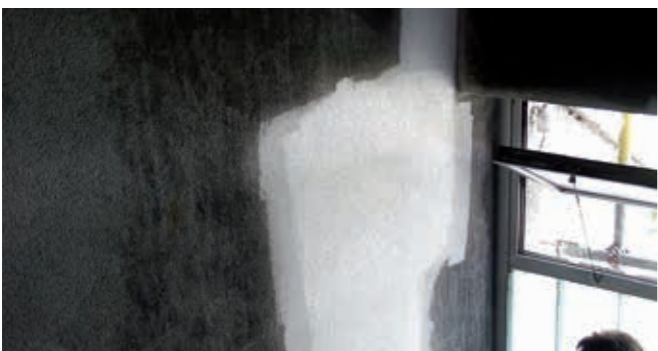
Renovace po požáru dvakrát provedeným nátěrem
